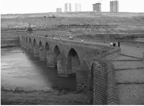
On Gözlü Köprü
